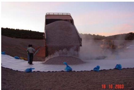
Déchargement de matériel de protection avec un camion
