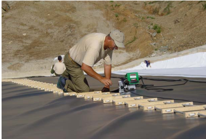
Soudure avec machine automatique à double soudure
