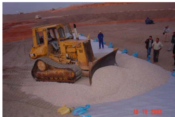
Distribution de matériel avec un bulldozer
