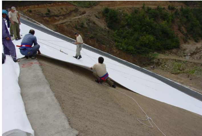
Mise en place du géotextile
