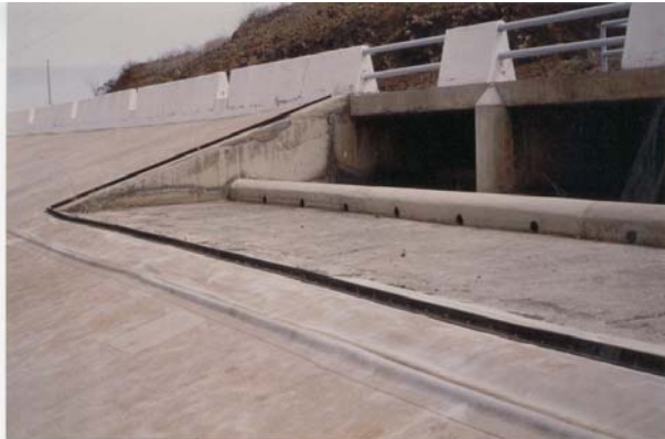
La connexion à la structure en béton à l'aide de bride / contre bride
