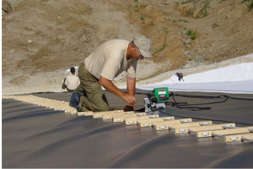
Soudure à l'air chaud par appareil à double soudure
