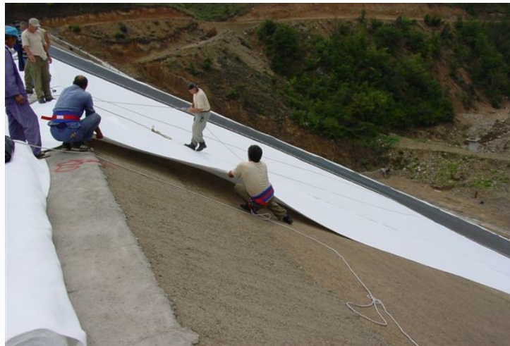
Mise en place du géotextile
