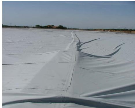
*Installation de flotteurs sous la couverture flottante*
