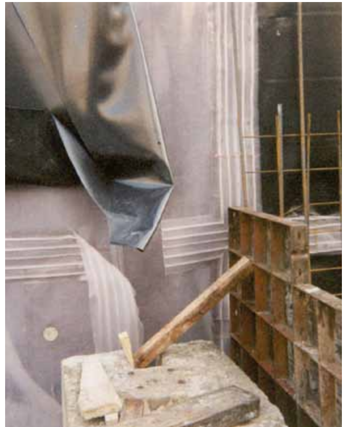
Installation des bandes d'arrêt d'eau
