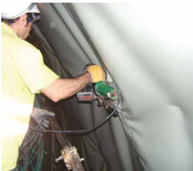
Machine automatique de soudure à air chaud
