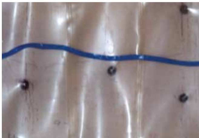
Tube d'injection soudé à la géomembrane
