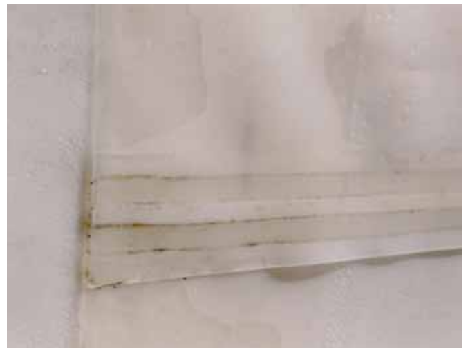
Double soudure de la membrane translucide
