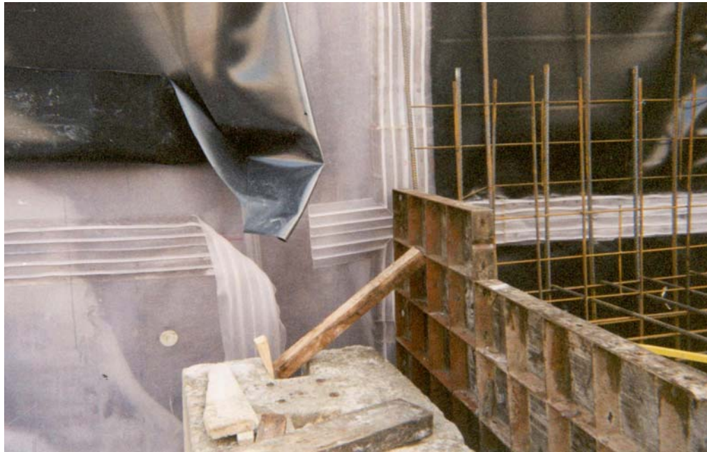
Installation des bandes d'arrêt d'eau
