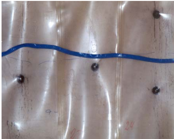
Tube d'injection soudé à la géomembrane
