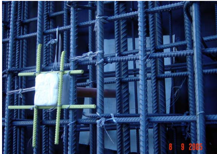
Protection de l'entrée du tuyau d'injection
