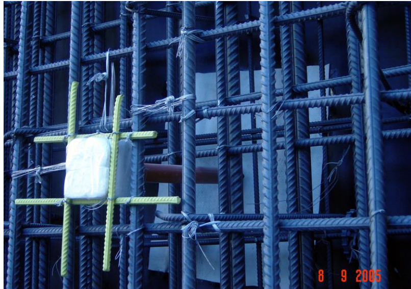
Protection de l'entrée du tuyau d'injection
