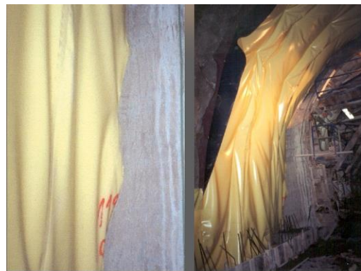
Tête de coffrage en béton
