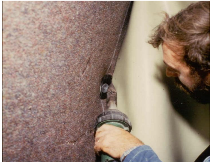
Fixation de la géomembrane par appareil manuel
