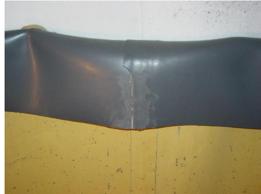
Préparation de la soudure pour point T
