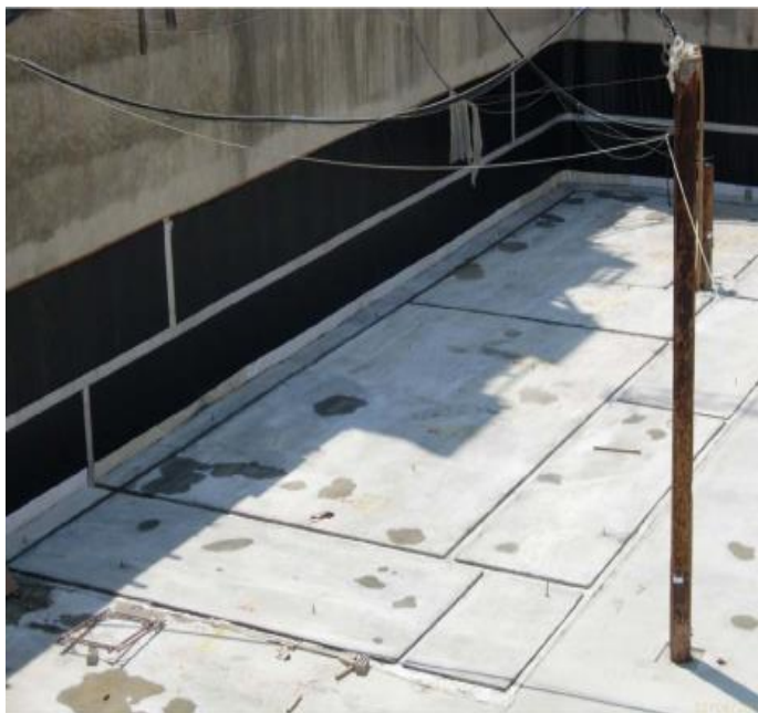
Fijación intermedia de la impermeabilización
