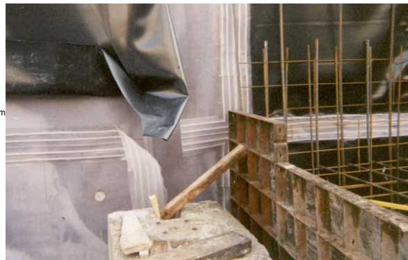
Ejecución del sistema de impermeabilización con water stops externos
