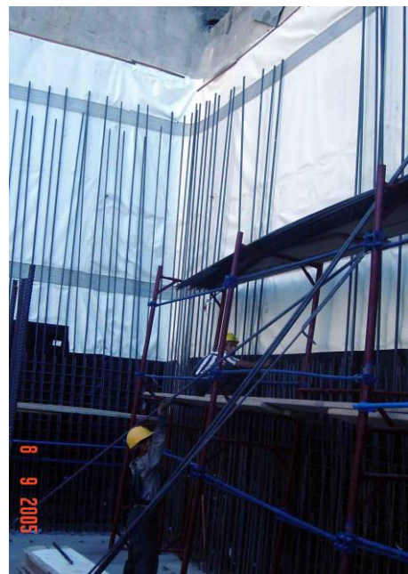
Fijación intermedia de la impermeabilización
