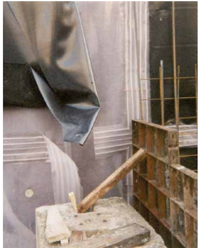
Instalación de waters stops
