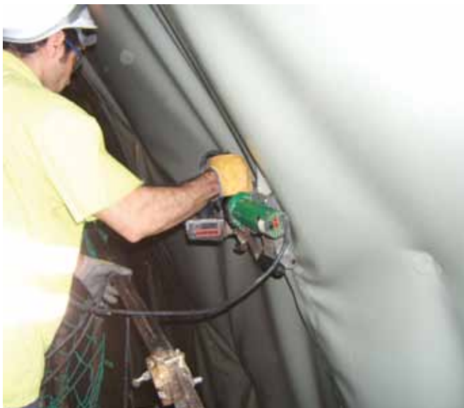
Máquina automática de soldadura de aire caliente
