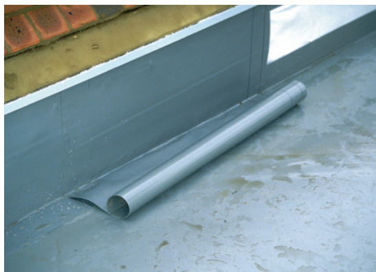
Figur 3: Kantfixering med RENOLIT ALKORPLAN stålprofil.
