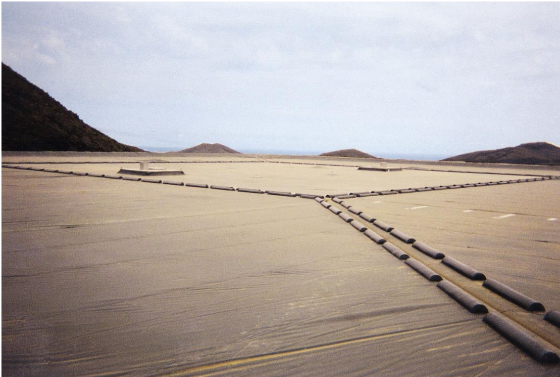
Cubierta flotante de la balsa ERSA
