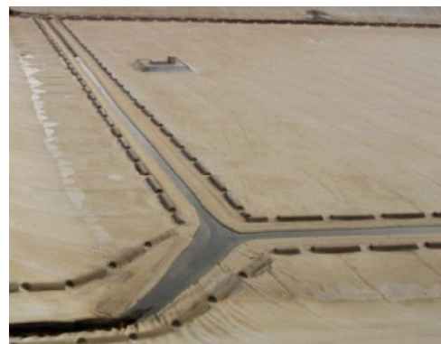
Desagüe para la lluvia desde el punto más profundo
