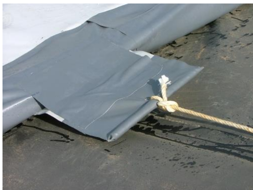
Piezas para tirar de la cubierta flotante
