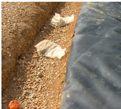
Zanja de anclaje
