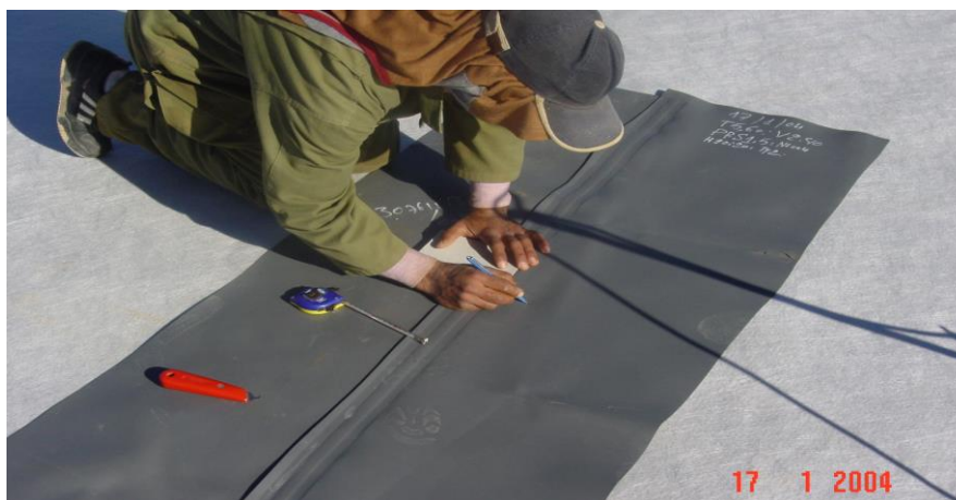
Prueba de soldadura
