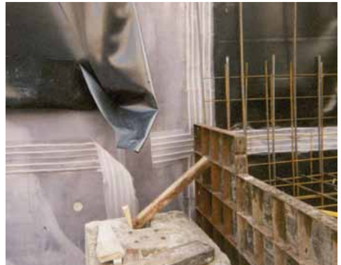
Losa protegida con Water Stops expuestos
