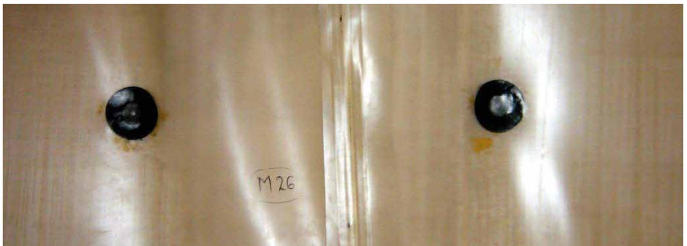
*Fijación de la geomembrana con soldadura directa*
