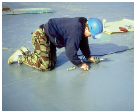
Figura 2: Verificarea realizării sudurii
