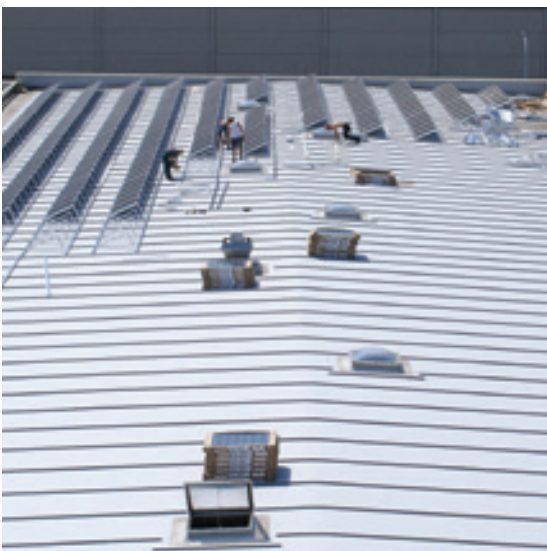
Kristallina solcellpaneler fästs direkt på RENOLIT ALKORSOLAR systemet.
