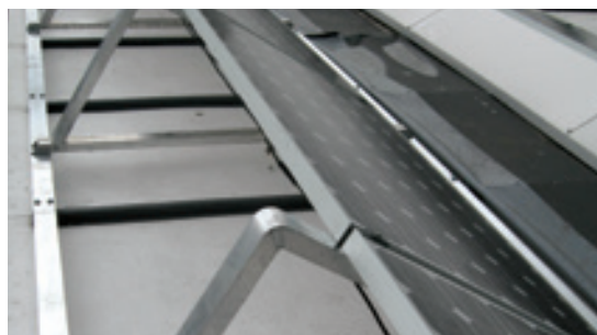
Bild 2: RENOLIT ALKORSOLAR som en bas för kristallina solceller
