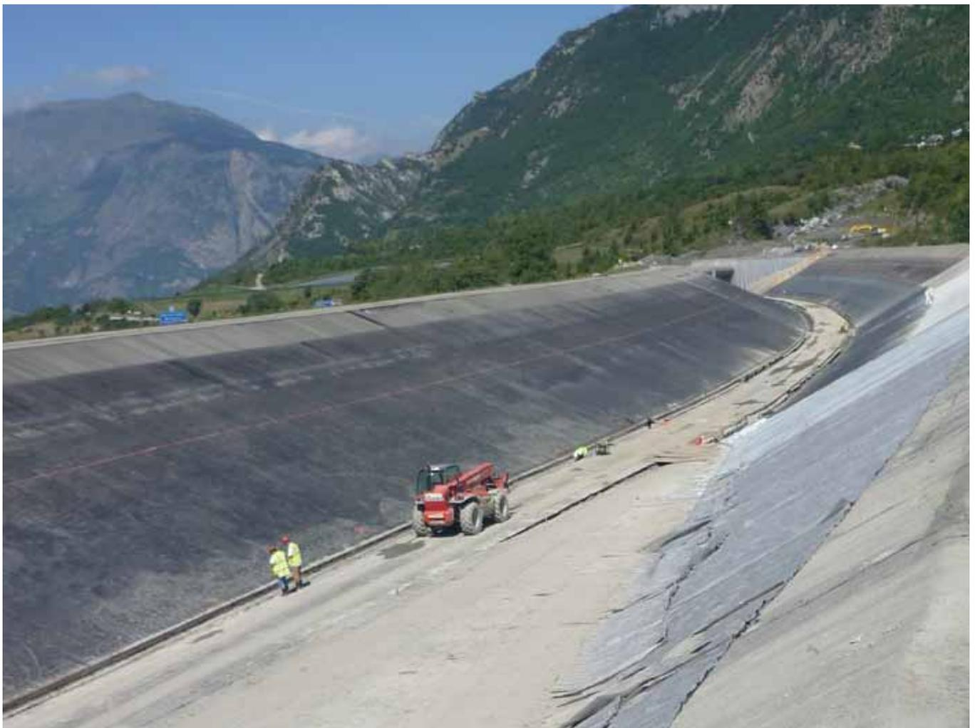
**Anclaje al principio y al final de la sección de impermeabilización**
