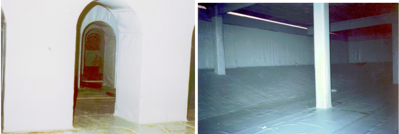
Impermeabilización de depósitos de agua potable
