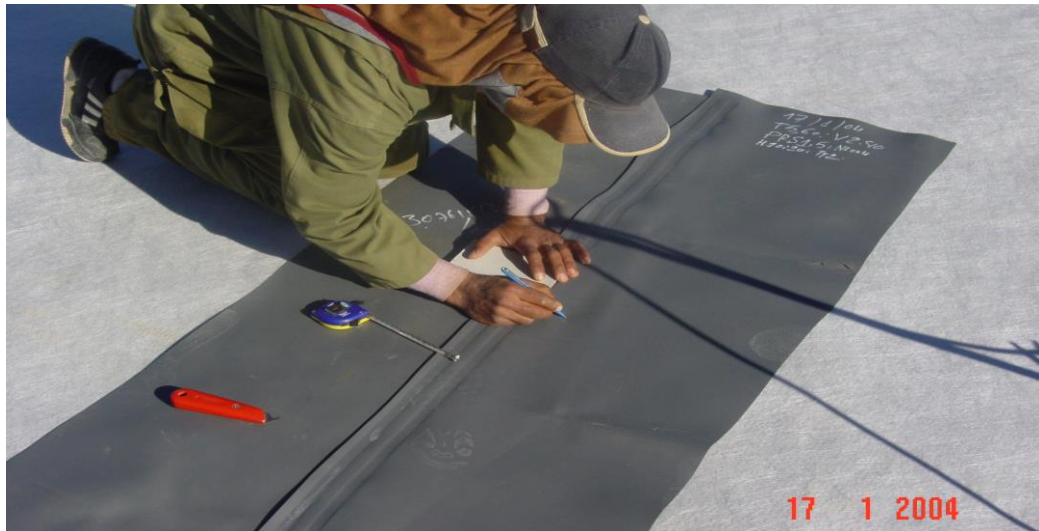
Prueba de soldadura
