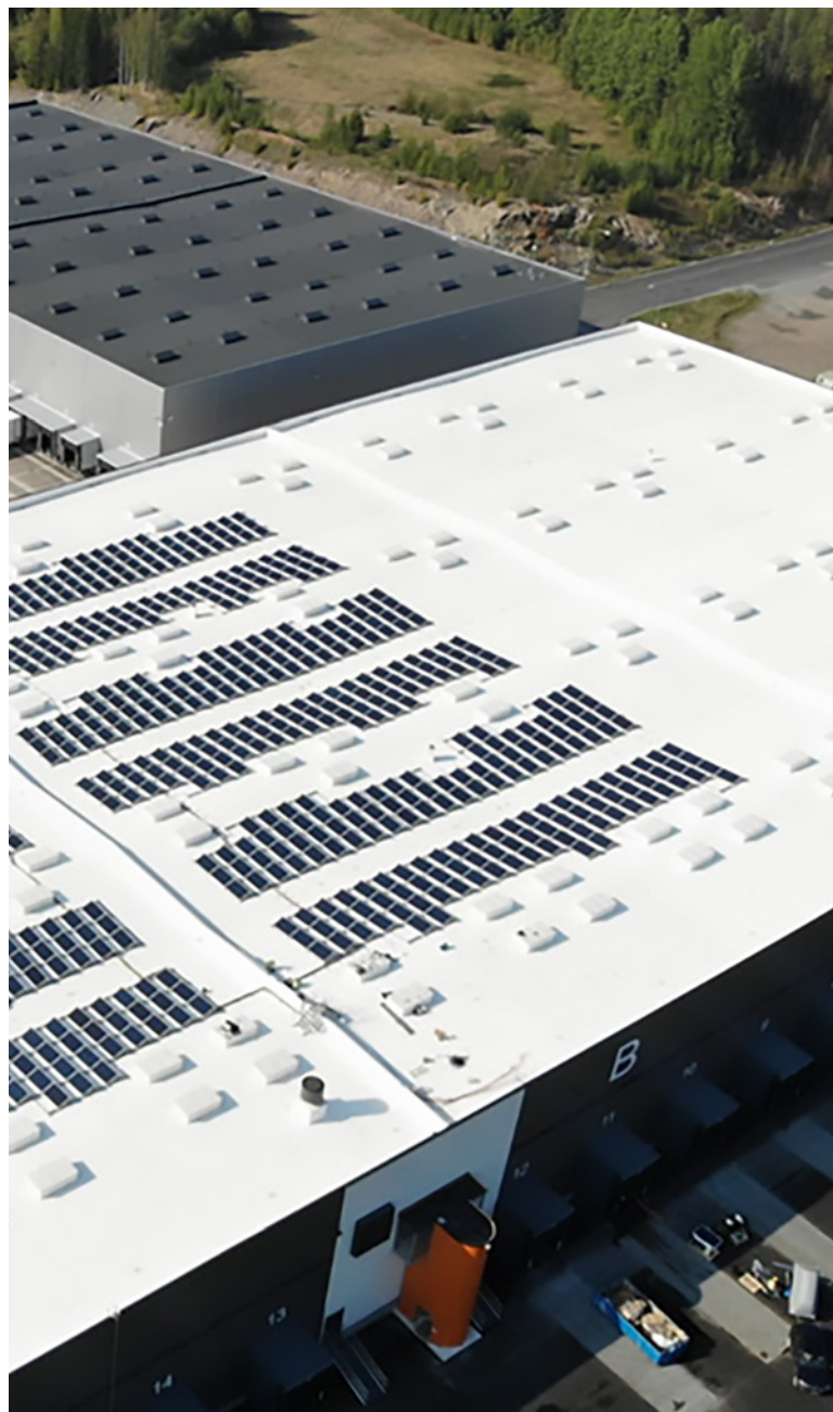
Bâtiment industrielle - Finlande 11 000 m 2 RENOLIT ALKORPLAN F + profilés RENOLIT ALKORPLAN Solar
