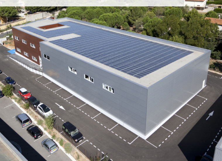
Agence EDF Montpellier – France 2 100 m 2 RENOLIT ALKORPLAN F + profilés RENOLIT ALKORPLAN Solar Crédits photos EDF ENR et Photec
